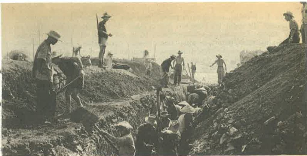
Construcción de fortificaciones en el perímetro de Dien Bien Phu.
